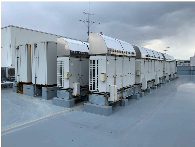
室外機群 施工前
